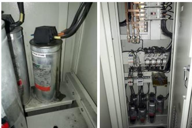
**Justificación:** el banco de capacitores está compuesto por elementos de desgaste; para el mes de abril de 2018, se realizó el cambio del capacitor paso 5 y paso fijo (dos unidades); de la subestación principal del sótano.
